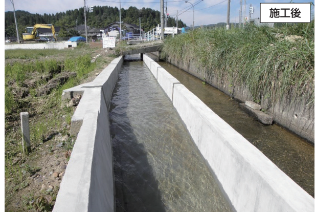
施工例（富山県高岡市 用水路の補修・補強工事）
