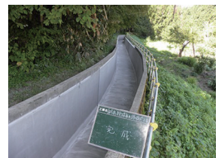
⑥養生・完了
