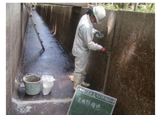
②欠損部のモルタル補修
