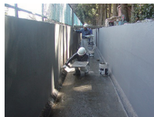
⑤モルタル塗り工
