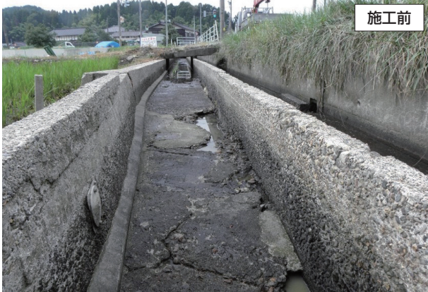
施工例（富山県高岡市 用水路の補修・補強工事）
