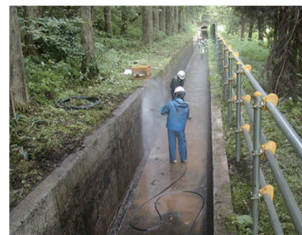
①高圧水による洗浄
